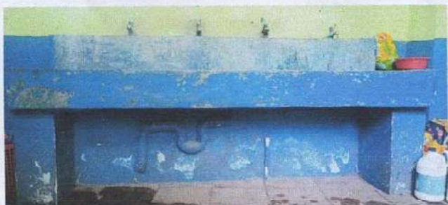
Foto 1: Sustitución de lavamanos gretados y con fuga de agua por lavamanos base de cemento y lavamanos incrustados de porcelana.
