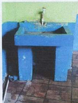
Foto 2: Sustitución de lavamanos quebrado y con fuga de agua por lavamanos de cemento.
