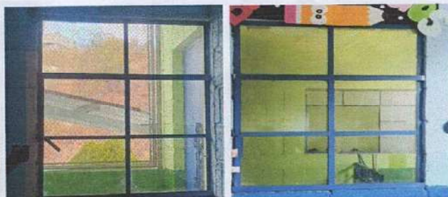
Foto 2: Sustitución de ventanas quebradas por ventanas de PVC en aulas.
