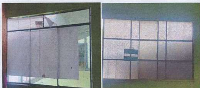
Foto 3: Sustitución de ventanas de metal en mal estado por ventana de PVC en aulas.
