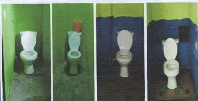
Foto 3: Sustitución de sanitarios lavables dañados que no permiten realizar descarga de agua, por sanitarios lavables.
